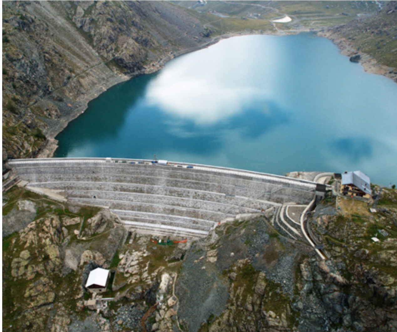
Diga del Gabiet
