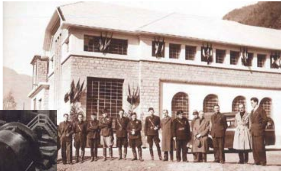
1941: inaugurazione centrale Bardonetto
