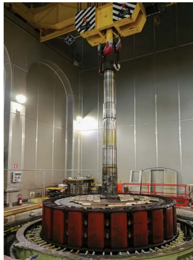
Estrazione rotore della centrale di Hône 1
