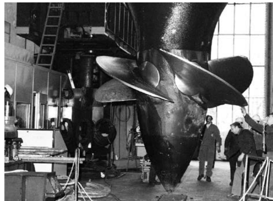
Agosto 1918 - Lavori in corso sulla girante Kaplan nella centrale di Hône 1.
